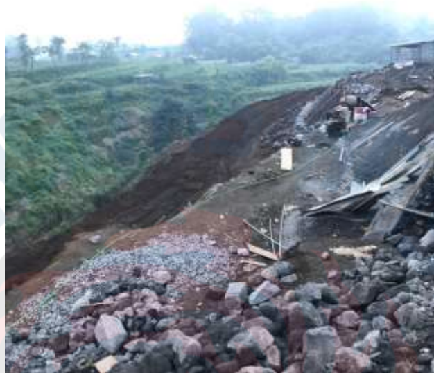
Gambar 3. Pembangunan Embung Desa Sumberejo
