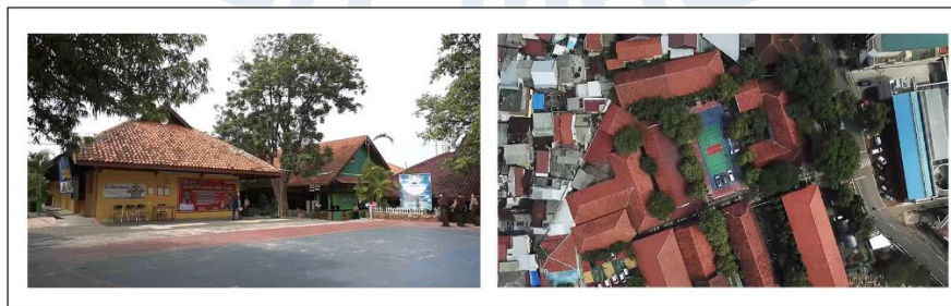
Gambar 11. Kondisi bangunan bekas kamp di masa sekarang
